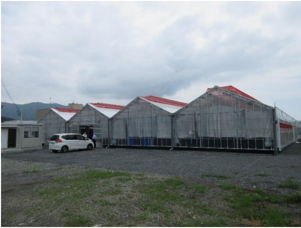
完成したアクアポニックスプラント
